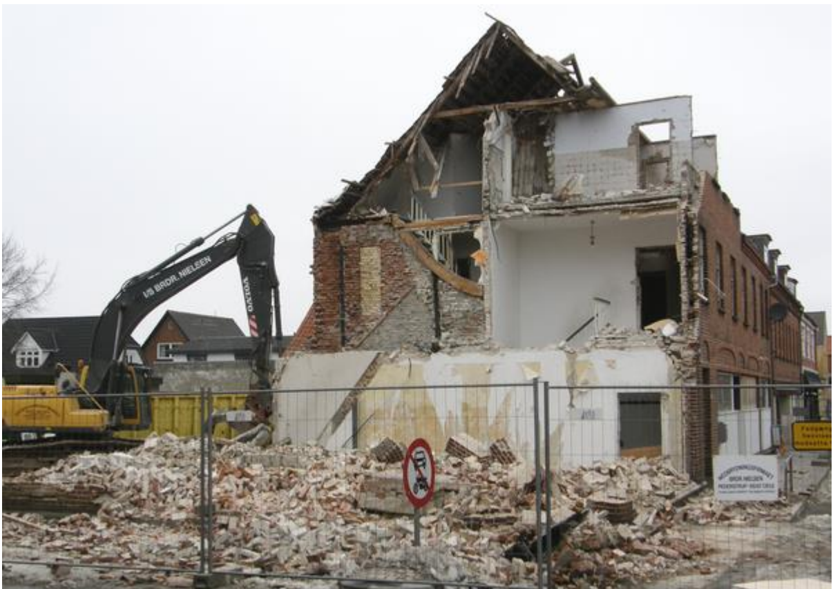
Vestergade 44 under nedrivning 2/3 2011.
